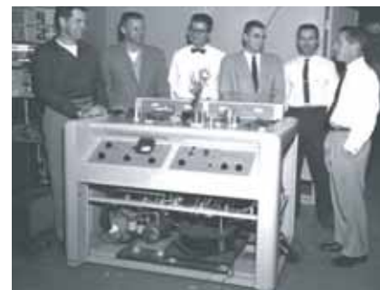
En la fotografía puede verse el primer grabador de video que fabricó la empresa Ampex en 1956 y que permitió a los estudios de televisión emitir programación grabada
