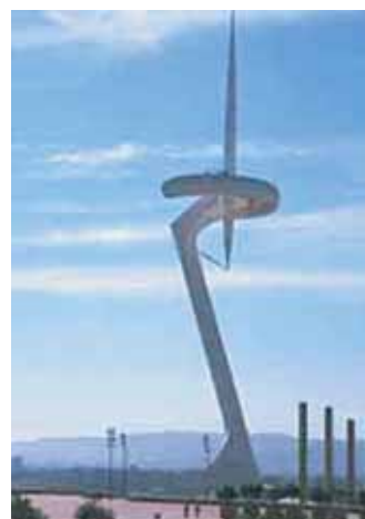
Fotografía de la Torre de Montjuich de 136 metros, obra de Santiago Calatrava, que Telefónica inauguró en Barcelona en 1992 para las comunicaciones de los Juegos Olímpicos
