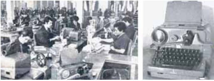
(Izquierda) Sala de Aparatos de Telégrafos en Madrid en 1968; como puede verse la mayor parte de los aparatos son teletipos de la nueva tecnología de la época (Derecha) Fotografía de uno de los teletipos más usados y fiables en Telégrafos entre los años 1960-80: el teletipo Siemens «pulga»
