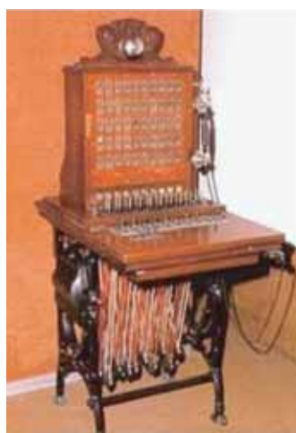
El desarrollo de la telefonía llevó a utilizar centrales manuales en las oficinas que permitían conectar a cualquier abonado que llamase con el llamado mediante una operadora. La central de la derecha prestó servicio en Barcelona
