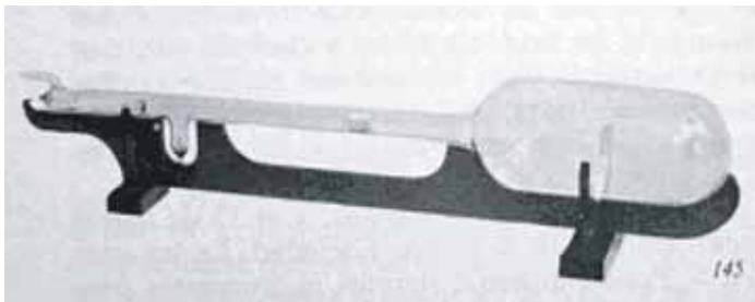
Carl Ferdinand Braun inventó en 1897 el tubo que llevaría su nombre y que se utilizaría posteriormente para el tubo de cámara de televisión electrónica y el tubo receptor de televisión electrónica
