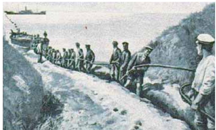
El comienzo y el final del tendido de un cable submarino habían de hacerse en el punto en que el mar toca tierra y era una operación laboriosa que exigía personal entrenado
