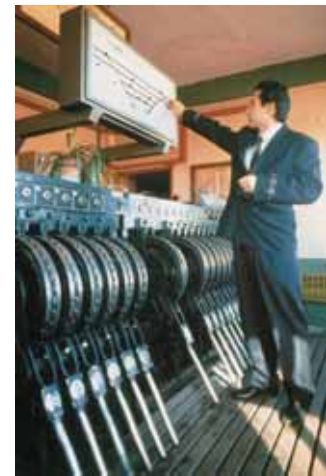
Enclavamientos mecánicos de concentración de palancas. El control del accionamiento de las agujas de cambio de vías se hacía desde la propia estación, evitando de esta forma el desplazamiento de un agente al punto donde se hacía el cambio
