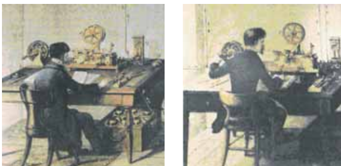
El dibujo de la izquierda representa un operador de la estación telegráfica emisora manejando el manipulador morse para transmitir un telegrama y el de la derecha un operador de la estación telegráfica receptora recibiendo el telegrama en código morse en cinta y traduciendo el código a papel mientras enrolla la cinta con la rueda envolvente. En ambas estaciones pueden verse los elementos adicionales –baterías, rueda envolvente etc.– además del manipulador y receptor morse
