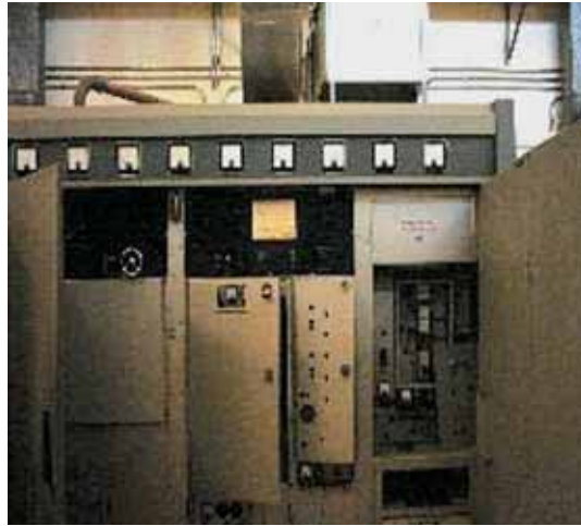
Estación transmisora de Pozuelo del Rey (Izquierda) y radio y equipo emisor de 30 KW (Derecha). La instalación procede de finales de los años veinte cuando Telefónica comenzó a explotar el servicio radiotelefónico internacional con América del Sur. Desde los años setenta se utiliza para prestar el servicio móvil marítimo radiotelefónico en Onda Corta
